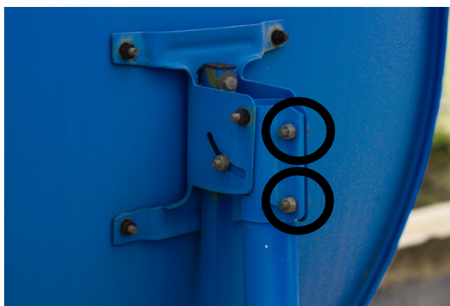
Imagen 24. Fijación de Elevación y Azimut
