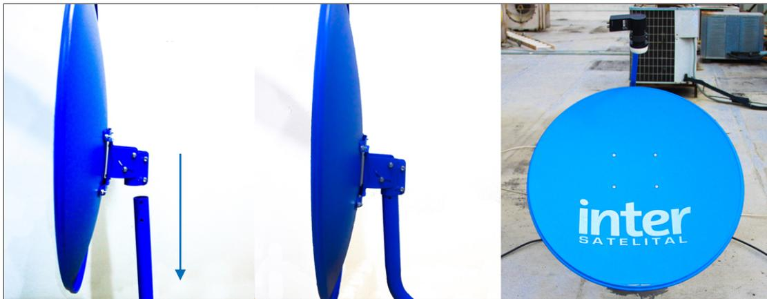
Imagen 19. Armado de Antena Inter Satelital.
