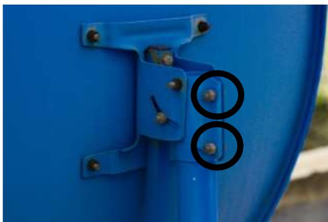
Imagen 24. Fijación de Elevación y Azimut
